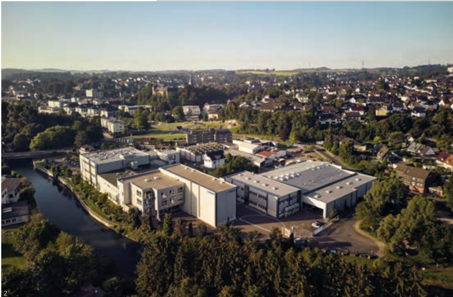
Abb. 1 – Werk II – PFLITSCH Kompetenzzentrum für Kabelkanäle Fig. 1 – Plant II – PFLITSCH centre of competence for cable trunking
